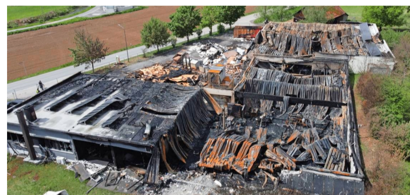
Nach dem Brand bietet das Gelände der Polzer Innenausbau GmbH & Co. KG in Jagsthausen nur noch ein Bild der Zerstörung. Foto: privat
