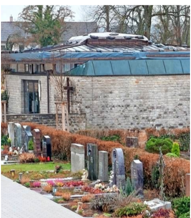
Das Dach der Aussegnungshalle wird für 66.000 Euro saniert. Foto: Ute Plückthun
